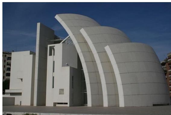
شکل ۱- کلیسای جوبلی، رم، ایتالیا. در نمای این سازه از بتن با ترکیب نانو ذرات دی اکسید تیتانیوم استفاده شده است.
