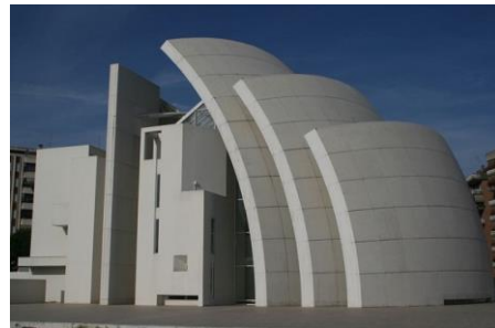
شکل ۱- کلیسای جوبلی، رم، ایتالیا. در نمای این سازه از بتن با ترکیب نانوذرات در اکسید تیتانیوم تشکیل شده است.
